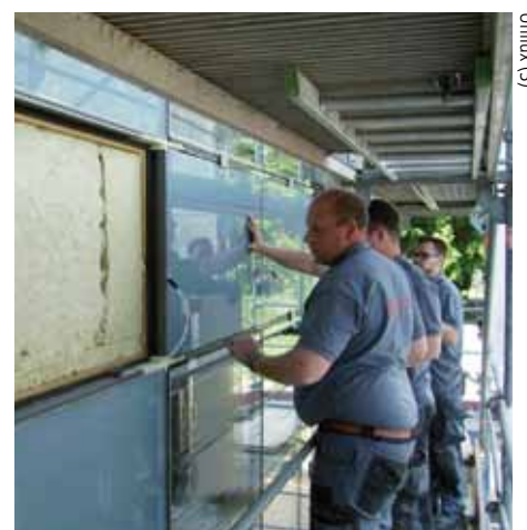
Die Montage der Pfosten-Riegelkonstruktion verlief reibungslos.
